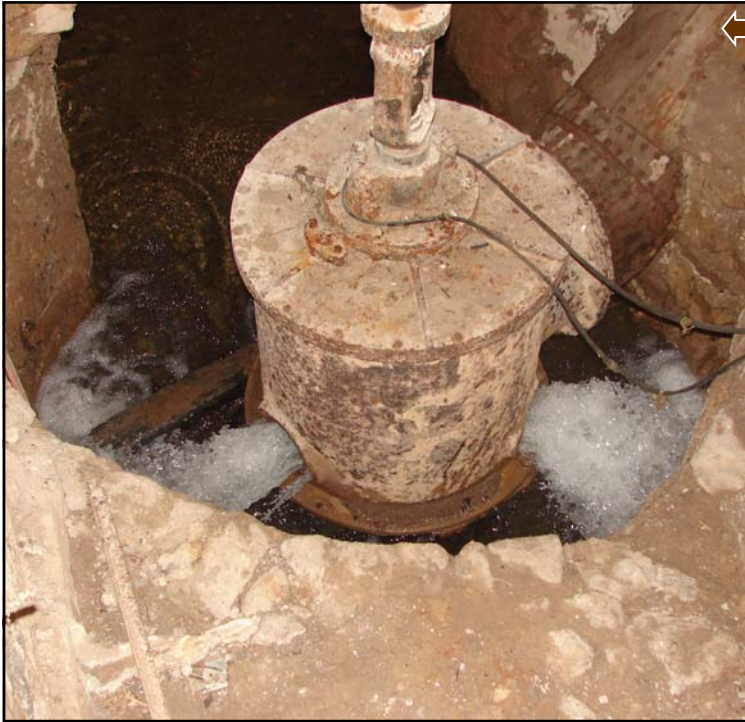
La turbine: sur la photo de gauche, l'eau est éjectée par les 3 ouvertures aménagées dans la paroi et normalement destinées au nettoyage des pales. En fonctionnement normal ces ouvertures sont obstruées. L'eau, amenée par la conduite forcée, est évacuée au niveau de la base.
