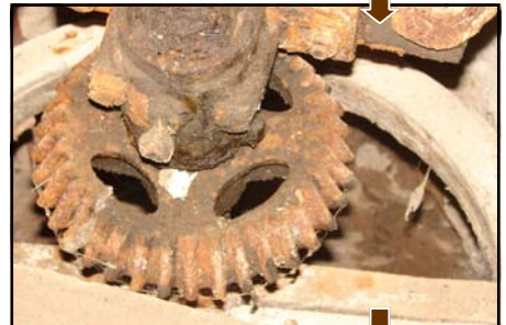
Vestiges des mécanismes de transmission, depuis l'arbre moteur.
