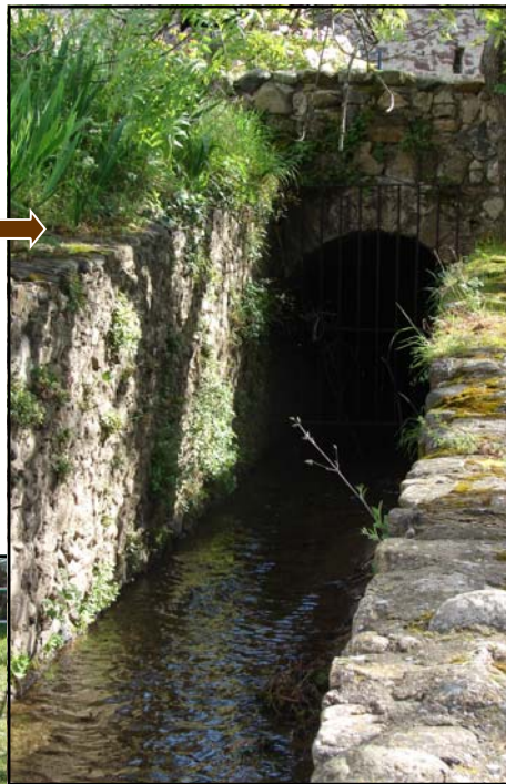
Canal d'évacuation de l'eau venant de la turbine, vers la rivière.
